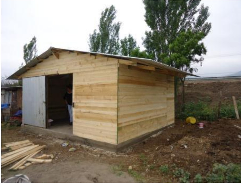
Foto N°9.- Construcción de Bodega de Almacenaje de forraje
