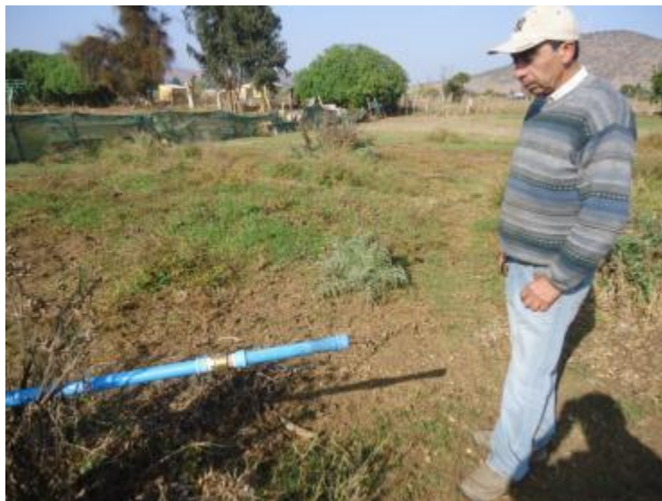
Foto N° 21 Sr. Luis Ojeda Ojeda Materiales Para Renovar Puntera
