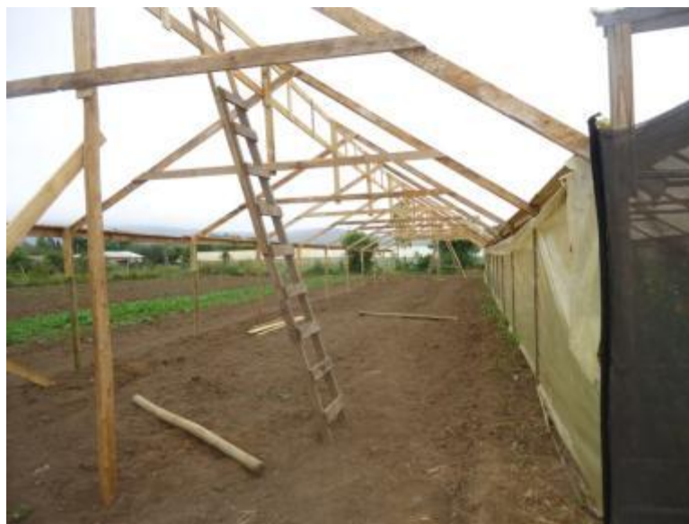
Foto N° 6 Construcción de Nave de Claveles
