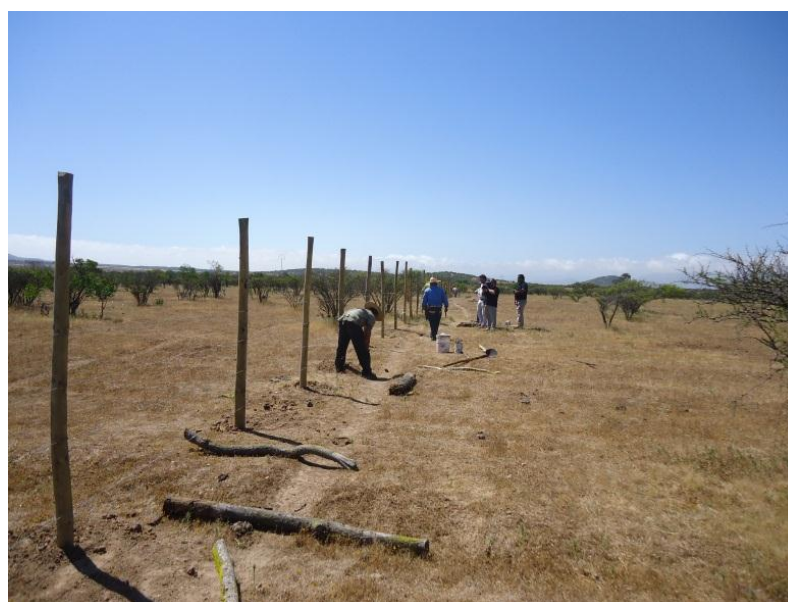
Foto N° 9 Faenas de instalación de postes
