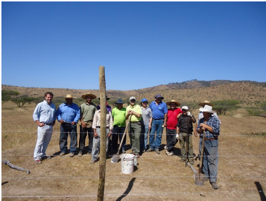
Foto N°8 Grupo de agricultor en Faenas de Instalación de Postes
